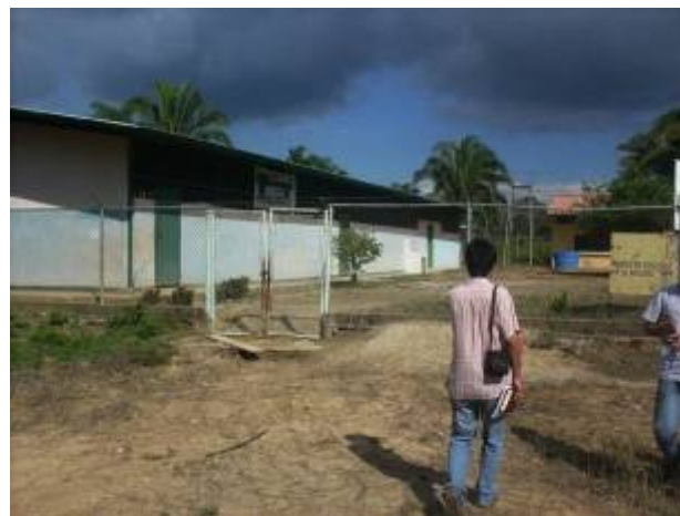
Escuela a Rehabilitar en el sector La Arenosa.
