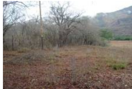
Construcción de cercas
