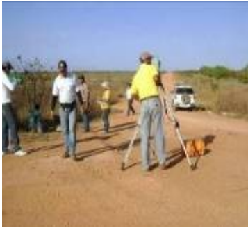
COLOCACIÓN Y NIVELACIÓN DE ESTACIÓN TOTAL PARA INICIO DE LAS MEDICIONES
