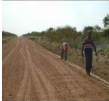
VISTA DE LA VÍA DE ACCESO ACONDICIONADA PARA LAS MEDICIONES
