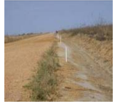
COLOCACIÓN Y NIVELACIÓN DE ESTACAS VÍA DE ACCESO BANCO DE PAVONES
