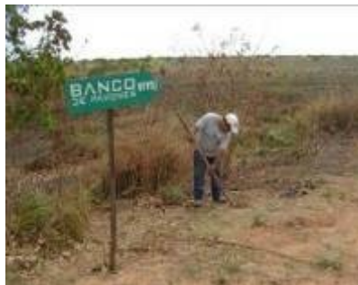
ORIFICIO PARA COLOCACIÓN DE PUNTO DE CONTROL EN LA INTERSECCIÓN
