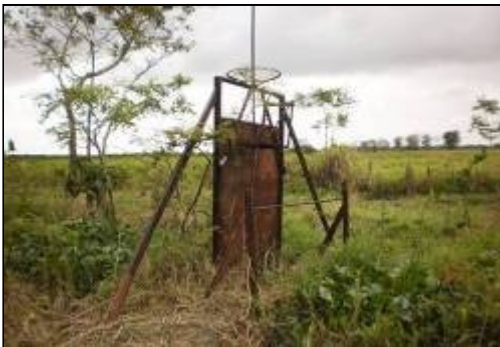
Estructura de control deterioradas (Sector Bucaral)
